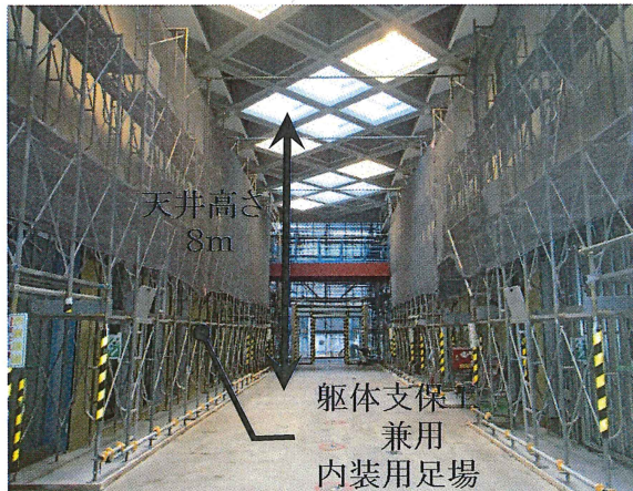
[ガレリア内装工事状況]
