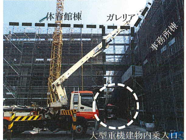
[躯体工事 大型車両乗入状況]
