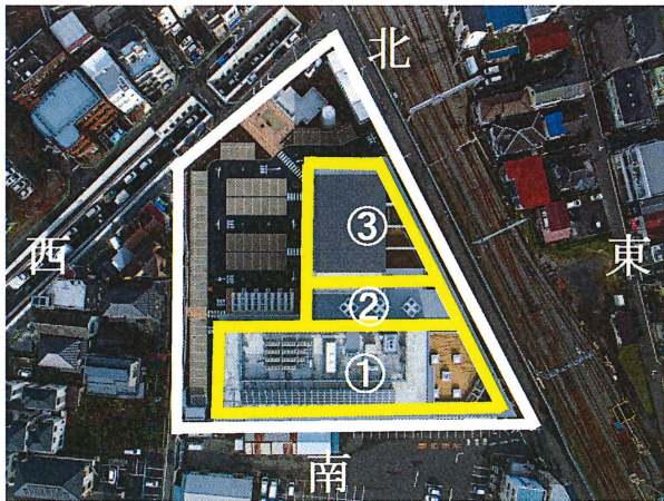
竣工写真：上空
