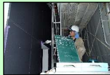
外壁シーリング
