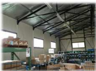
倉庫の屋根裏
