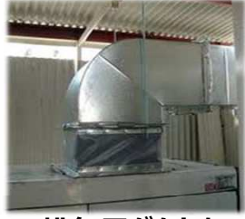
排気用ダクトを 接続して、断熱する
